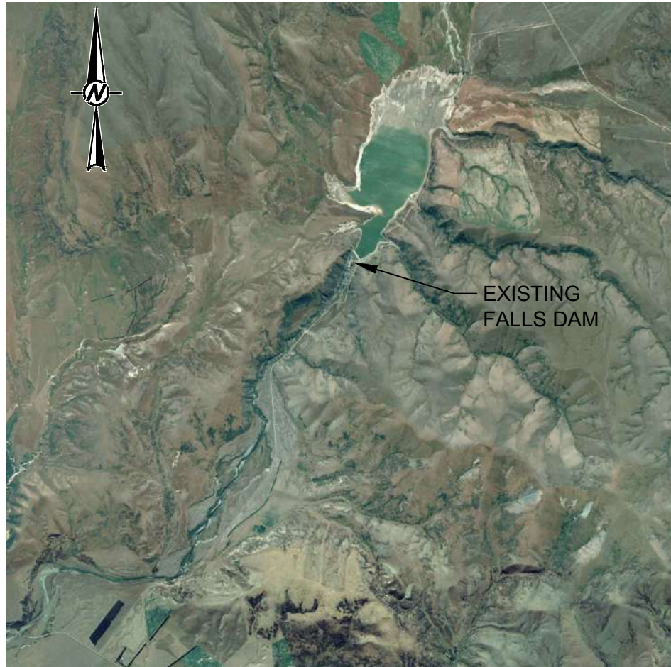
SITE PHOTO N.T.S.
